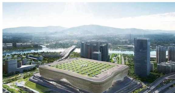
皇岗口岸联检大楼
