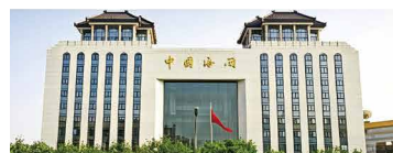
构建OTN系统环，满足海关各类业务综合入算
