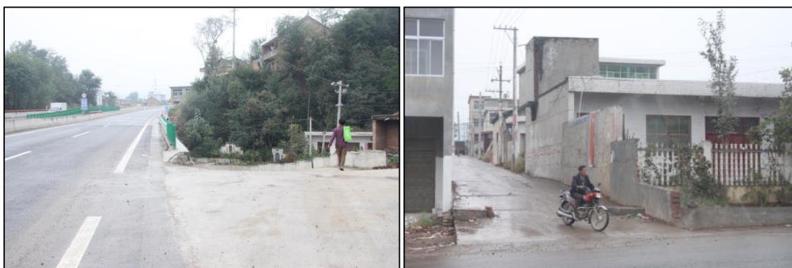
图 1-6 平交口通视三角区有植被、建筑物等障碍物导致视距不良
