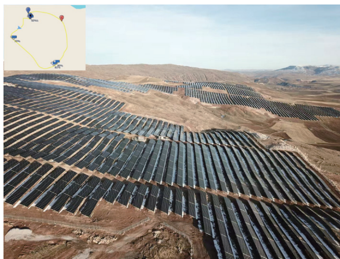
▲ 图1 巡检视频和无人机航迹结合，为项目管控提供数字化依据
