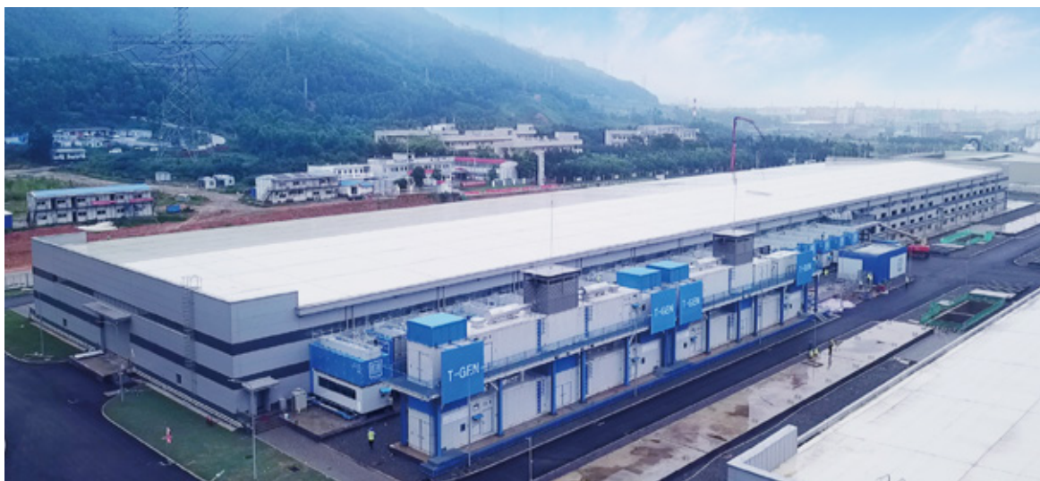
图2 预制全模块数据中心建设项目实景
