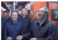
中国联通青海三江源 高原绿色数据中心
