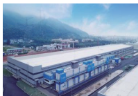
腾讯TB数据中心群 3.6万+机柜，满意度NO.1
