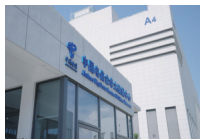
中国电信浙江金华 913机柜，EPCO
