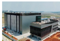
印度尼西亚DHI数据中心 20MW · UPTIME Tier III
