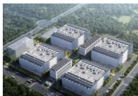
中国移动粤港澳 多层间蒸空调，AI调优
