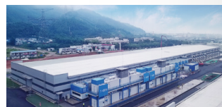
腾讯TB数据中心群 3.6万+机柜，满意度NO.1
