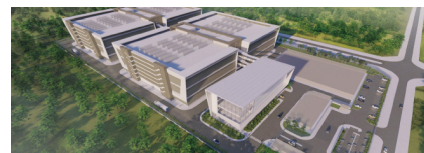
印度尼西亚DHI数据中心20MW · UPTIME
