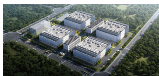
中国移动粤港澳 多层间蒸空调，AI调优
