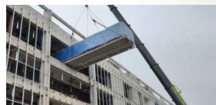
字节跳动芜湖算力中心 预制化IT模块
