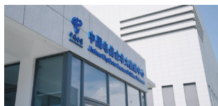
中国电信浙江金华 913机柜，EPCO
