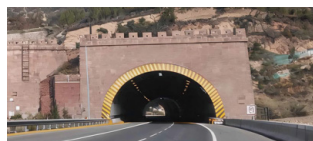
山西高速智慧隧道
