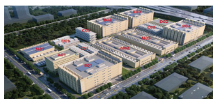
中国移动庆阳工业化数据中心 预制化集装箱应用
