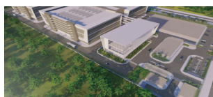
中国电信印尼DHI数据中心 连续两期规模交付
