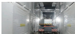
金融某山洞数据中心 高效预制交付，充分自然冷
