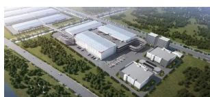
京东昆山数字产业园项目 多层间接蒸发空调
