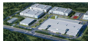
中国移动甘肃兰州新区数据中心 预制电力模块应用
