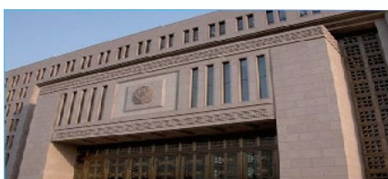
某部委大数据 云数据中心项目
