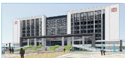
浙江绍兴政务 云数据中心项目
