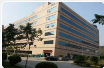
鹏城金云 金融数据中心
