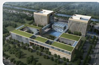
中国银行 西安、合肥数据中心
