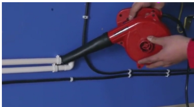
图 5-3 管道吹风定位
