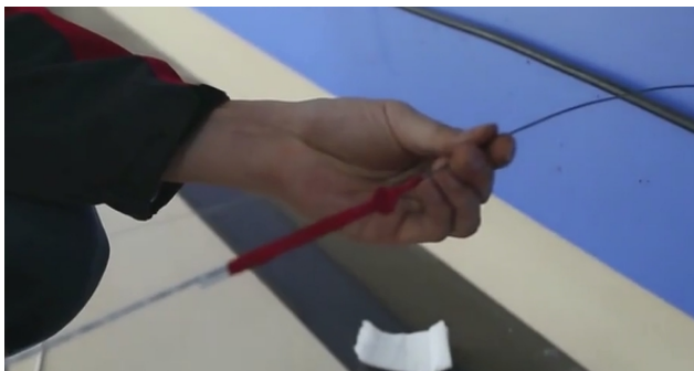
图 5-1 利用胶带把光缆与旧线进行缠绕捆绑
