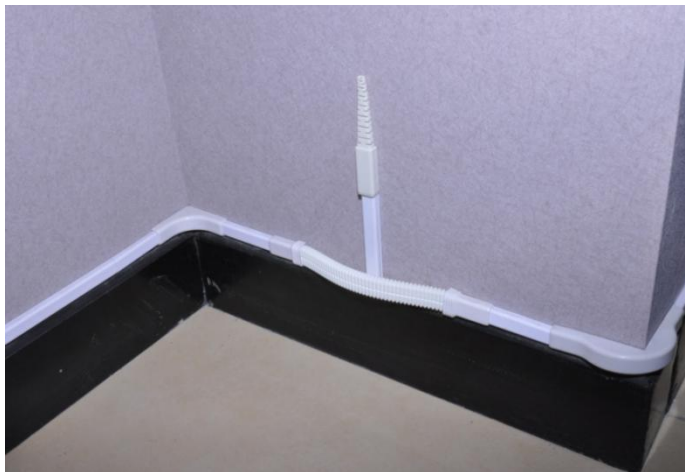
图 5-9 在线槽内敷设光缆
