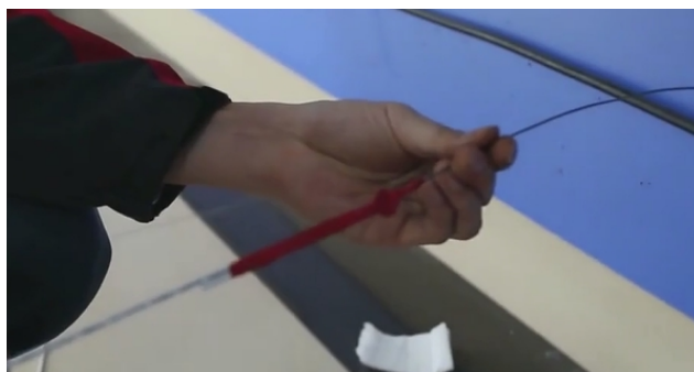
图 5-4 利用胶带把光缆与旧线进行缠绕捆绑
