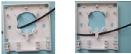
图 5-15 皮线光缆穿过光纤面板的底盒
