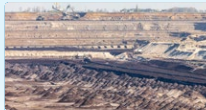
矿山爆破区域警戒及监控
