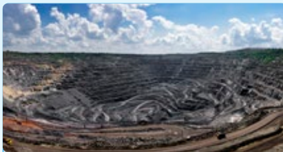
矿山日常巡检及目标识别
